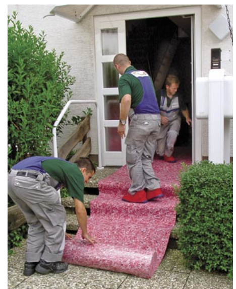
Der rote Teppich: Wenn die Laufwege bei größeren Arbeiten abgedeckt werden hinterlässt dies bei den Kunden einen guten Eindruck und verhindert Verunreinigungen
