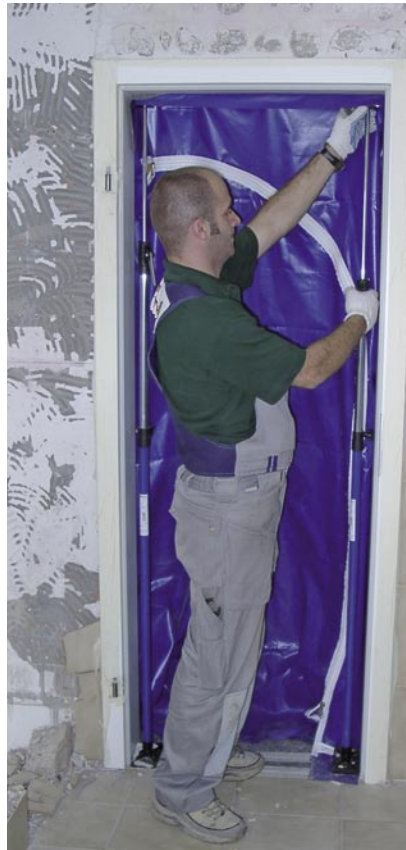
Die Staubschutztüre lässt sich mittels Komplett-Montage-Set in gängige Türrahmen klemmen. Im Bild: Modell A mit Durchfahrmöglichkeit (z.B. für Schubkarre)
